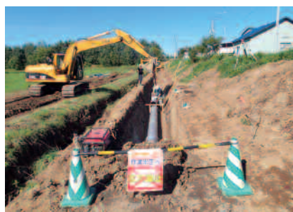
1工区用水路工
