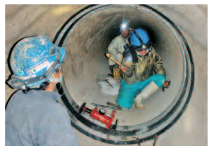
止水バンド設置
