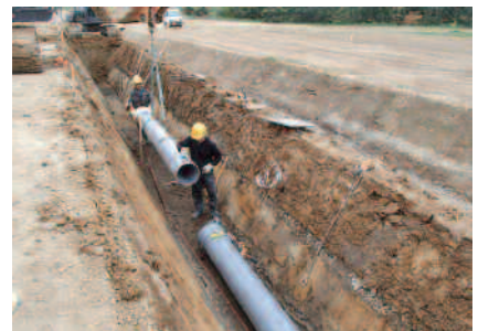
1工区用水路工
