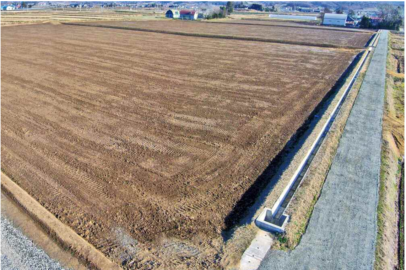
杵臼西部地区61工区
