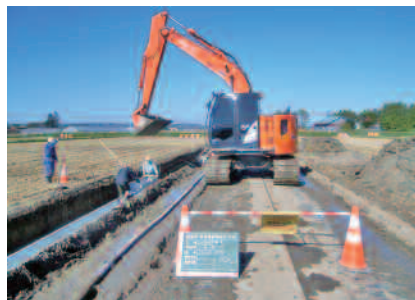
61工区排水路工
