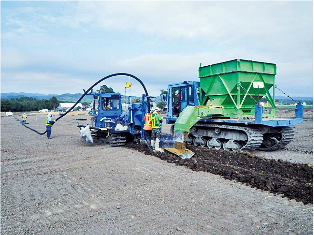
南角田北部41工区
